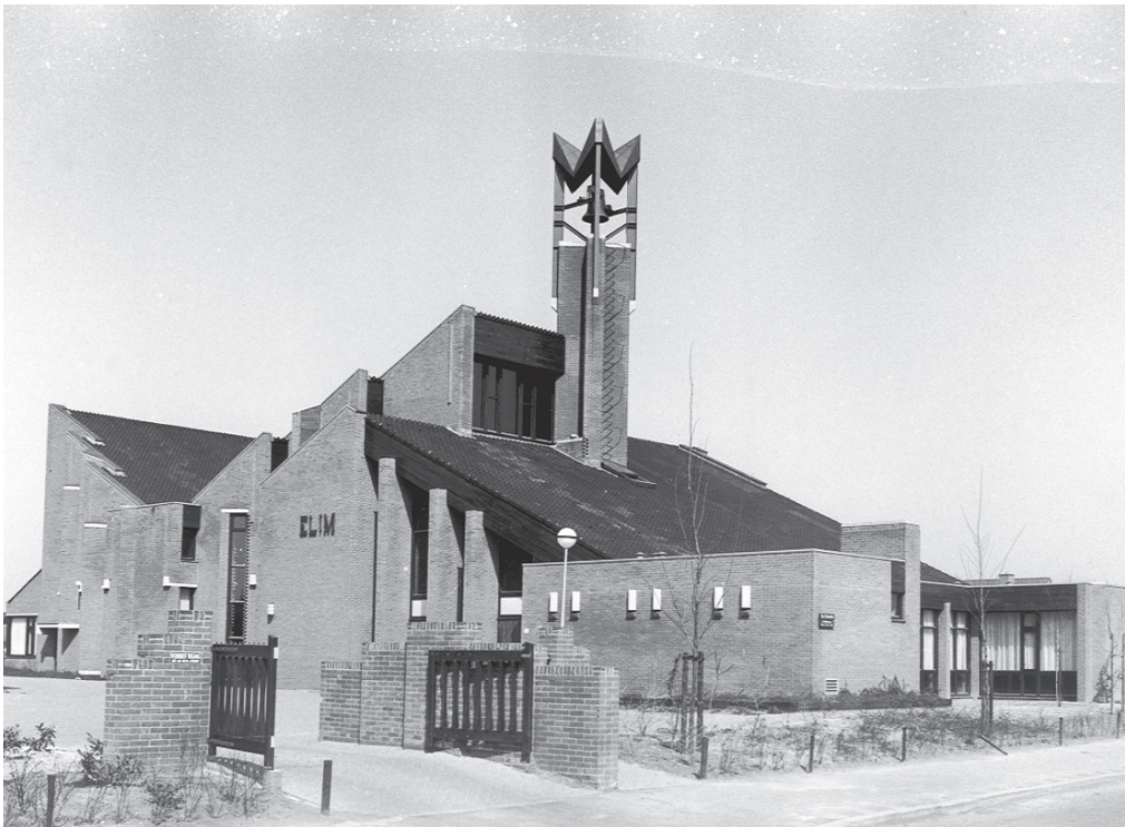
De Elimkerk op een foto die kort na de bouw genomen is.
