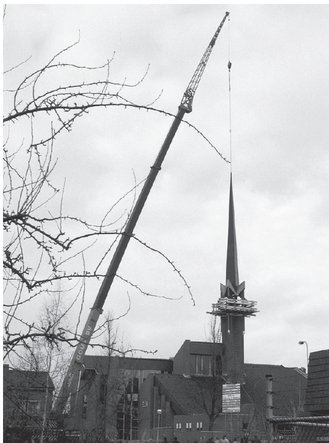
Bij de verbouwing werd de toren heel wat hoger. Het plaatsen van de torenspits trok vanzelfsprekend nogal wat belangstelling.
