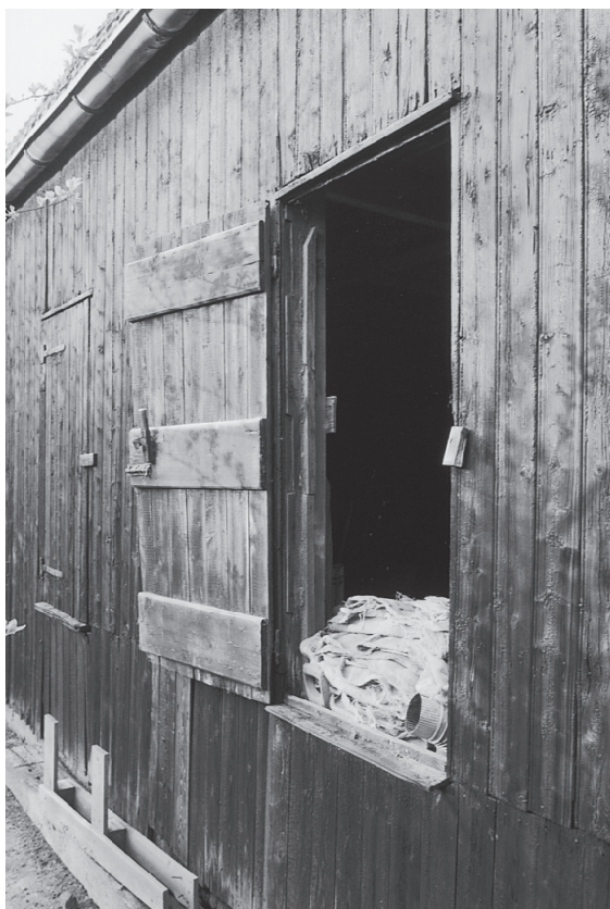
De schuur van Felijs; duidelijk zichtbaar zijn de ventilatieopeningen.
